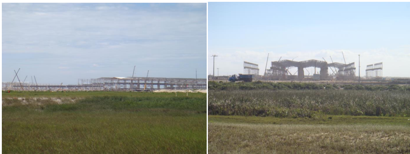
Obras do porto a todo vapor no Açú
